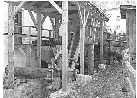
Abb. 148: Sta. Maria V. M., Mühle Mall. Die Antriebskonstruktion der Mühle mit Holzkanal und unterschlächtigem Strauberrad, welches den Mahlgang im Innern antreibt.
