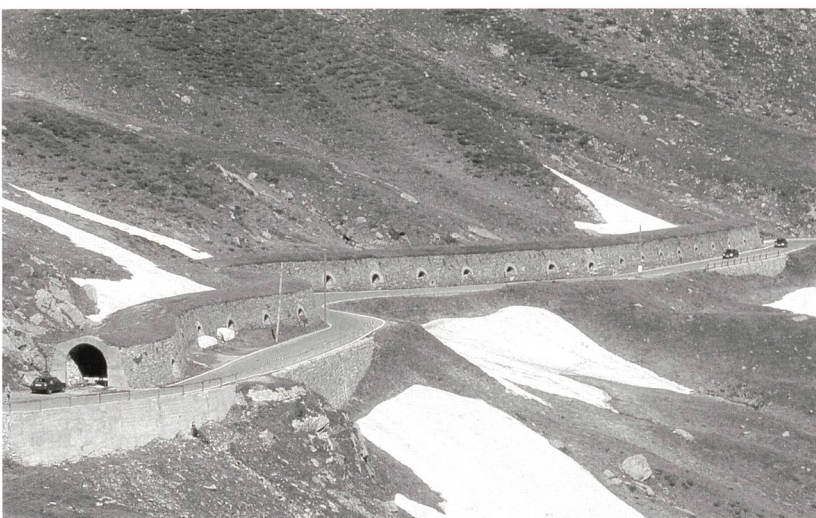
Abb. 70: Splügen, Galerie am Splügenpass. Zustand vor der Restaurierung. Blick gegen Nordwesten.
