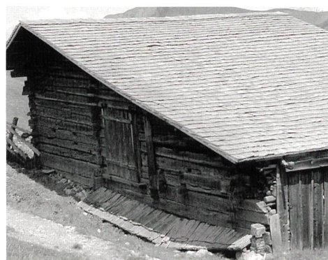
Abb. 96: Safien, Zalön, Alpstall/Einzelsennerei (Stupli). Nachzustand des Schindeldaches. Blick gegen Nordosten.
