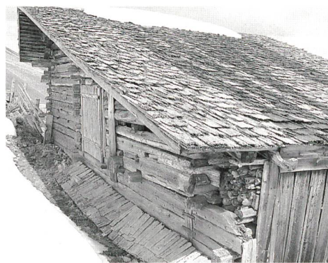
Abb. 95: Safien, Zalön, Alpstall/Einzelsennerei (Stupli). Vorzustand des Schindeldaches. Blick gegen Nordosten.
