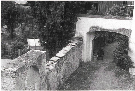
Abb. 71: Haldenstein, Schloss. Umfassungsmauer Süd nach Entfernung des Bewuchses und Reinigung der Mauerkrone. Blick gegen Südwesten.
