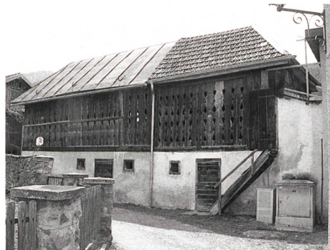
Abb. 73: Ilanz, Parzellen Nr. 192/193. Die zwei an die Stadtmauer angebauten Ställe vor dem Abbruch. Blick gegen Süden.
