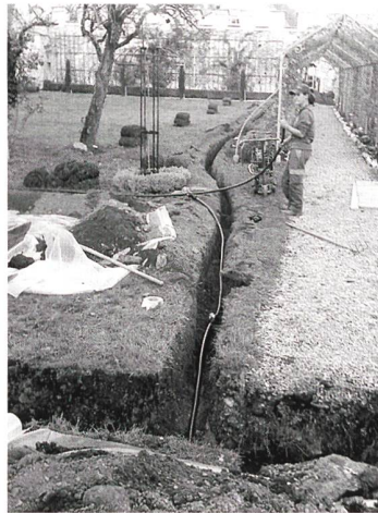
Abb. 72: Haldenstein, Schloss. Schlossgarten, Gräben für die Leitungen zur Bewässerung des Rosengartens.
