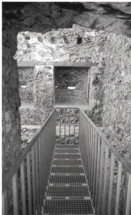
Abb. 113: Brienz/Brinzauls, Burganlage Belfort. Neuer Aufstieg im vierten Geschoss des Torturms.
