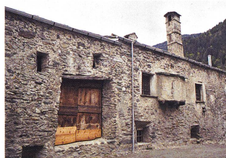
Fig. 117: Poschiavo, Borgo, Casa Tomé. Vista facciata nord. Situazione dopo il restauro.
