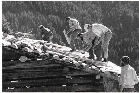
Abb. 127: Peist, Barge Nr. 57. Neuverschindelung des Daches.
