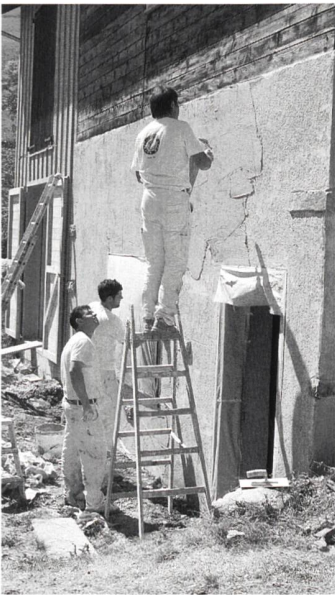
Abb. 126: Morissen. Restaurierungsarbeiten an der Alten Mühle Nr. 97.
