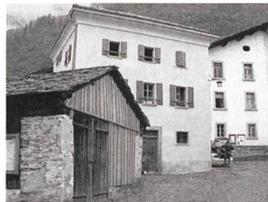
Das im historischen Ortskern von Soglio gelegene, dreigeschossige Haus mit symmetrischer Fassadenaufteilung stammt vom Ende des 19. Jh. Die Arbeiten umfassten die Restaurierung der Fassaden und die Erneuerung des Steinplattendaches.
