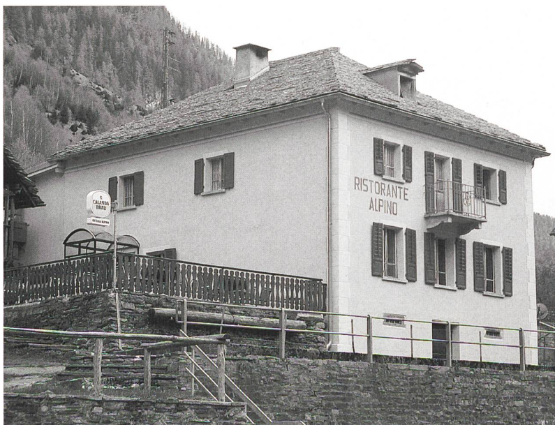
Fig. 154: Rossa, ristorante «Alpino» no. 57. Vista da nord-ovest. Situazione dopo il restauro.
