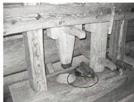
Bei der Restaurierung der Mühle in den Jahren 2001–04 wurde auch der Antrieb der zugehörigen Stampfe wiederhergestellt. Deren zwei Stössel wurden nun unter Einbezug noch vorhandener Bauteile anhand von Vergleichsobjekten rekonstruiert.
