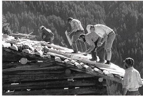
Abb. 127: Peist, Barge Nr. 57. Neuverschindelung des Daches.
