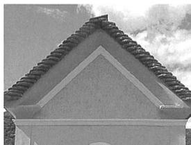
Die Kapelle in Pianezzo wurde einer Gesamtrestaurierung unterzogen. Die Fassaden wurden in der ursprünglichen Fassung mit Purkristallfarben gestrichen. Das Dach ist mit Steinplatten neu eingedeckt worden.
