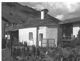
Die 1677 erbaute Kapelle musste nach einem Wasserschaden neu mit Steinplatten gedeckt werden. Aussen wurde sie frisch gekalkt.
