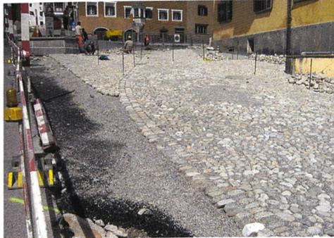
Abb. 145: Zuoz, «Plaz», während der Pflasterungsarbeiten.
