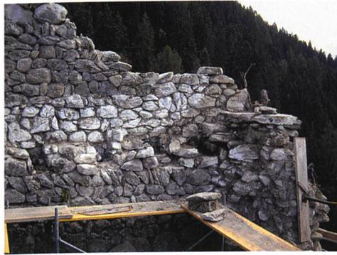
Abb. 143: Zillis-Reischen, Burgruine «Tur». Südost-ecke mit Torschwelle und Balkenauflegern des dritten Geschosses in gereinigtem Vorzustand.
