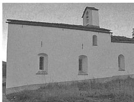
Die bereits 1405 genannte Kapelle litt unter den Auswirkungen der 1937/38 erfolgten Verbreiterung der Kantonsstrasse. Neben Reparatur und Entfeuchtung der Aussenwände soll die Erstellung einer Schutzmauer künftig die Situation verbessern.
