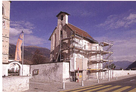
Abb. 18: Müstair, Kloster St. Johann. Heiligkreuzkapelle mit Fassadengerüst. Blick gegen Nordosten.
