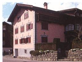
Restauriert wurde die aus dem frühen 19. Jahrhundert stammende, eigenwillige Dekorationsmalerei bestehend aus Fenstereinfassungen und Eckquaderung in Grisaillemanier mit plastischer Stuckwirkung auf dem rosa gefärbten Untergrund der Strick-Vormauerung.
