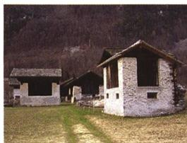
Die Stallscheune ist Bestandteil einer reizvollen, gut erhaltenen Baugruppe südlich von Bondo. Die Restaurierung umfasste die Neueindeckung des Steinplattendaches und die teilweise Erneuerung des Holzwerks.
