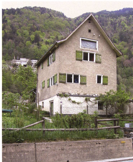
Abb. 171: Chur, Sandstrasse Nr. 19: Das bis ins Frühjahr 2008 bewohnte Haus aus dem Jahre 1618. Blick gegen Osten.
