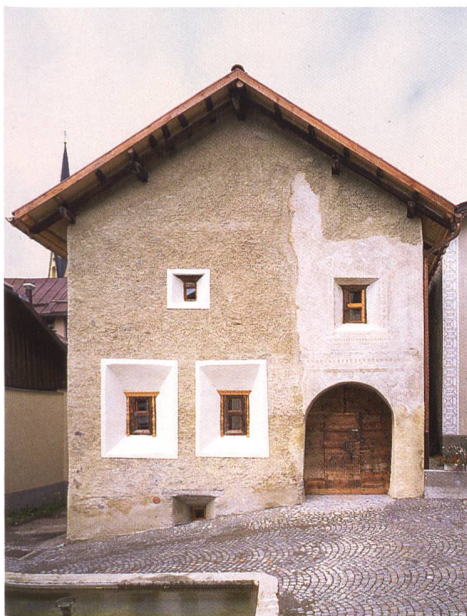
Abb. 112: S-chanf, Haus Nr. 120. Anzahl, Grösse und Proportionen von Gebäudeöffnungen prägen die Gebäudefassade entscheidend mit.
