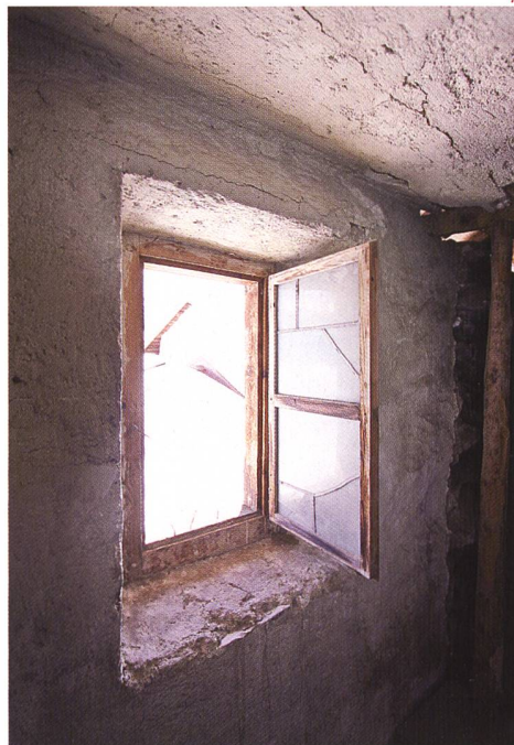
Abb. 116: Tschlin, Haus Nr. 48. Fensterreparaturen zeigen die Wertschätzung des vorhandenen Materials. Historische Reparatur des Fensterglases mit Bleiruten.
