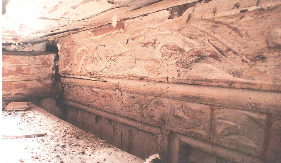
Die Schlafkammer wurde nur geweißelt. Mit Stützen und Unterzügen wurde dem Durchbrechen des Deckentäfers entgegen gewirkt, bis Ende 19. Jahrhundert ein neues Übertäfer eingebaut wurde.
