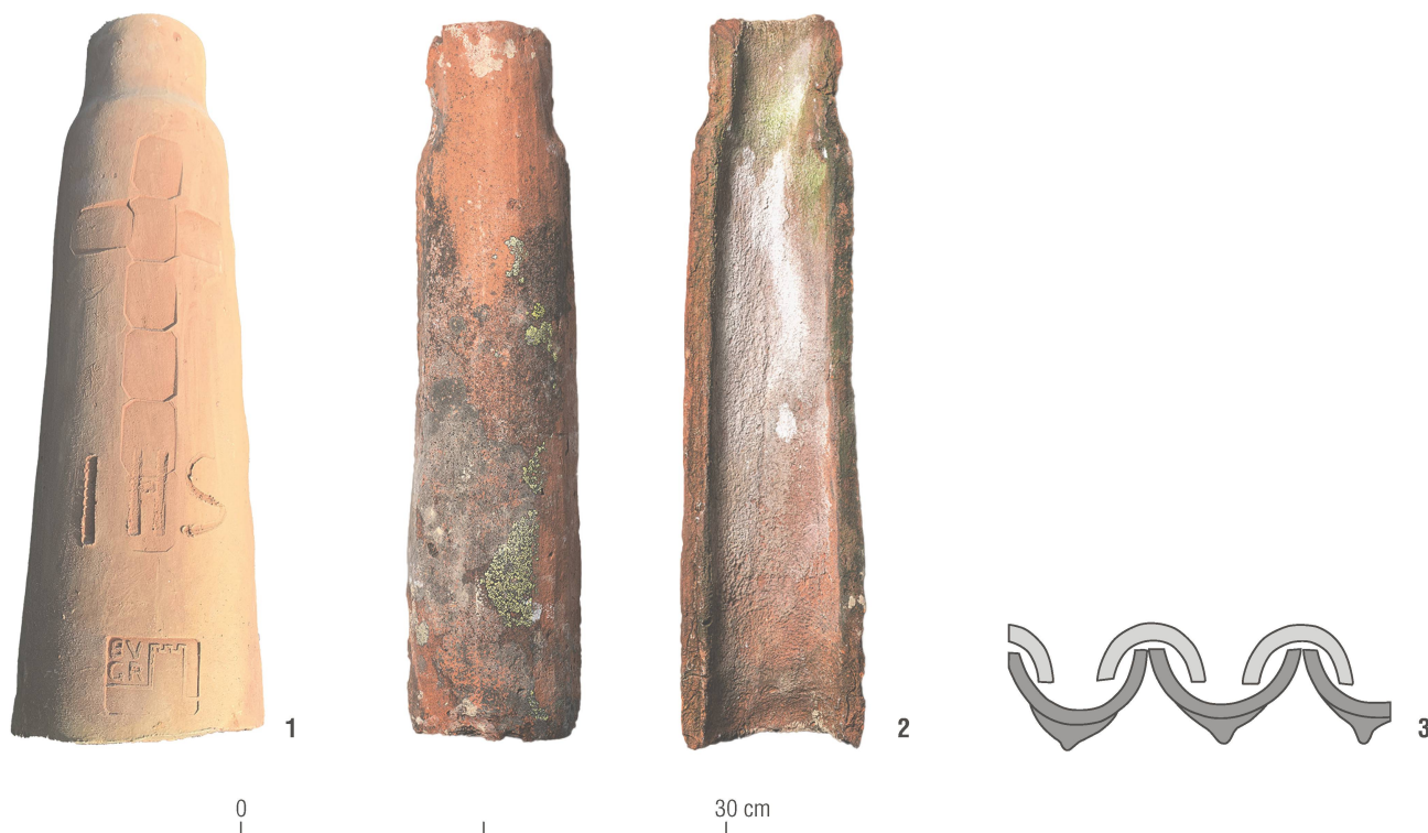
Abb. 6: 1 Replik eines Hohlziegels (Mönch) nach dem Brand im Holzfeuer, verziert mit einem Kreuz, dem christlichen Kürzel IHS und dem Stempel des Burgenvereins Graubünden. 2 Original eines mittelalterlichen Hohlziegels vom Hauptturm der Burganlage Neu-Aspermont. Mst. 1:5. 3 Eindeckung mit Hohlziegeln, schematisch: Nonne (dunkelgrau) und Mönch (hellgrau).
