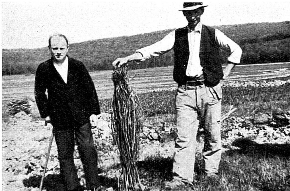
Dans les terrains imperméables (marne), afin que l'eau de la couche supérieure pénètre jusqu'aux drains d'évacuation, des faisceaux de branchages sont placés verticalement dans les tranchées. La photographie montre l'un de ces faisceaux que tient le maître draineur. A côté de lui, le président du syndicat de Beurnevésin.
