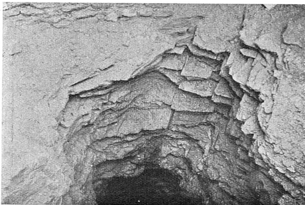
Le puits s'est progressivement vidé jusqu'à une profondeur de 60 mètres.
