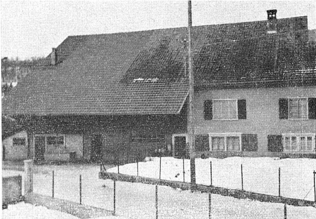
Courchapoix, exploitation morcelée dont les bâtiments ont été maintes fois transformés et agrandis.
