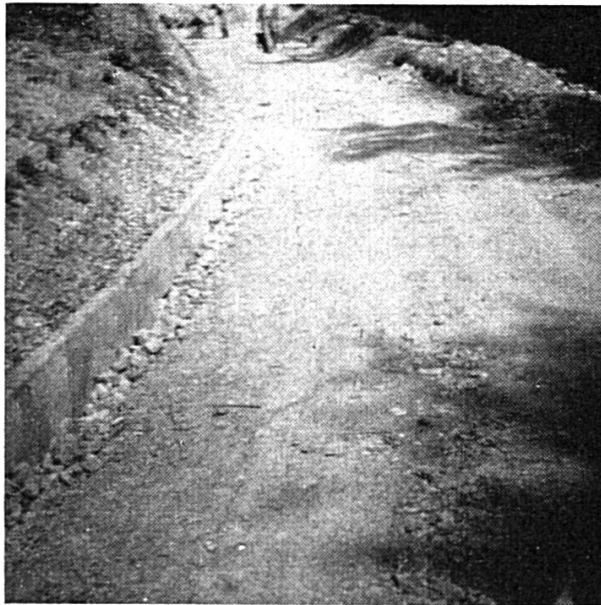
Coffre avec pierres de bordure en béton armé
