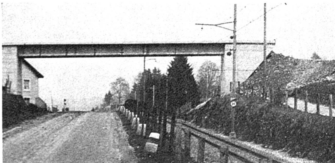
Le pont de la gare de Muriaux
