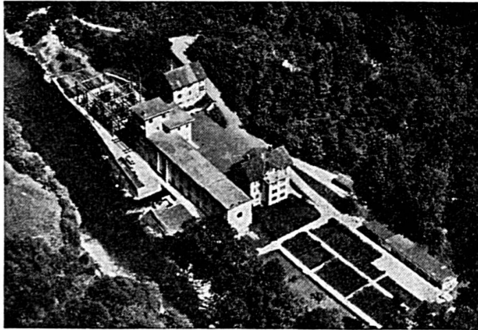
USINE DE LA GOULE SUR LE DOUBS
