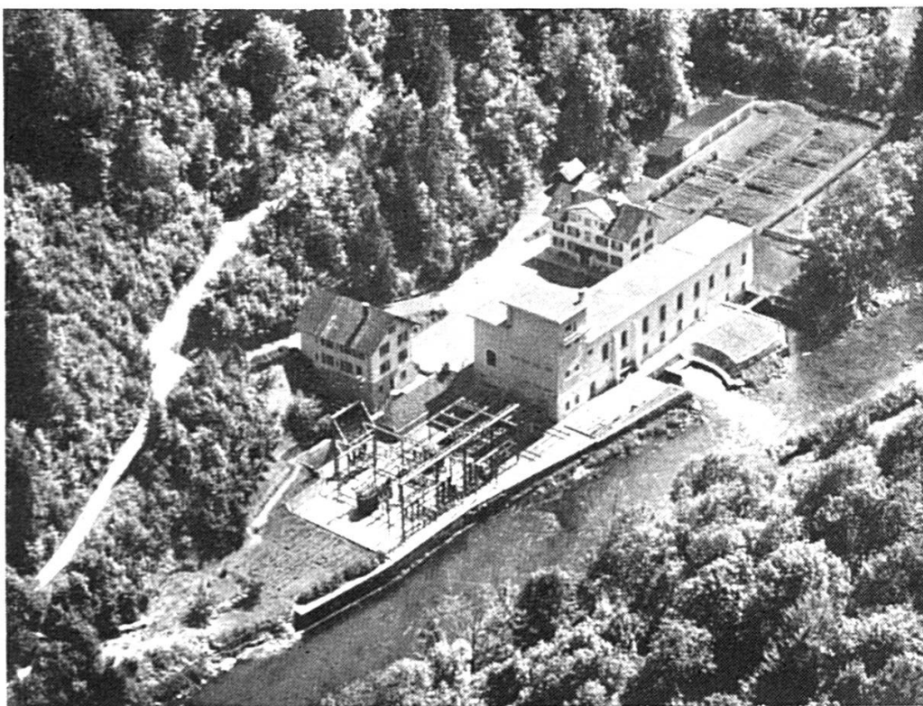
USINE DE LA GOULE SUR LE DOUBS
