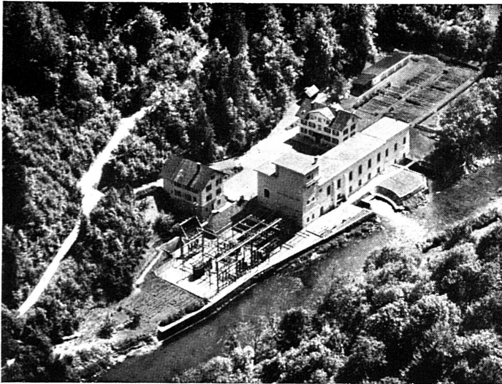
USINE DE LA GOULE SUR LE DOUBS
