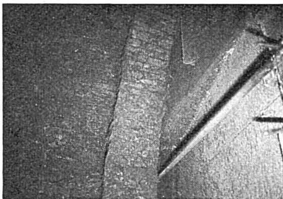
La Theurillate : vue partielle de la « voûte » et le canal d'évacuation de la fumée.
