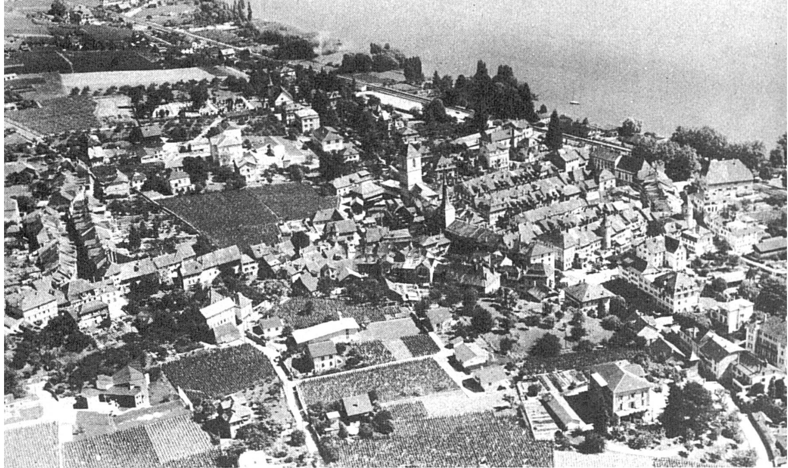
▲ ④ La Neuveville (photo aérienne Swissair)
