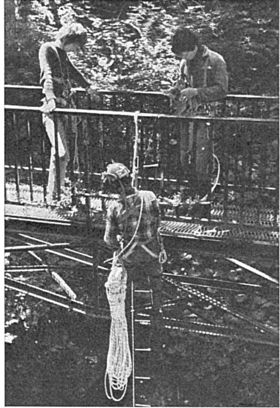
La passerelle supplant le gouffre de la Malaterre.
