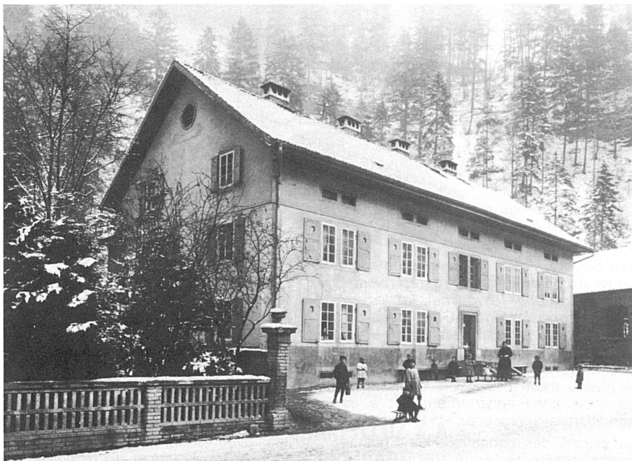
La "Laborantenhaus" : une des plus anciennes maisons ouvrières, construite avant 1873 et démolie en 1973 pour faire place au garage.
