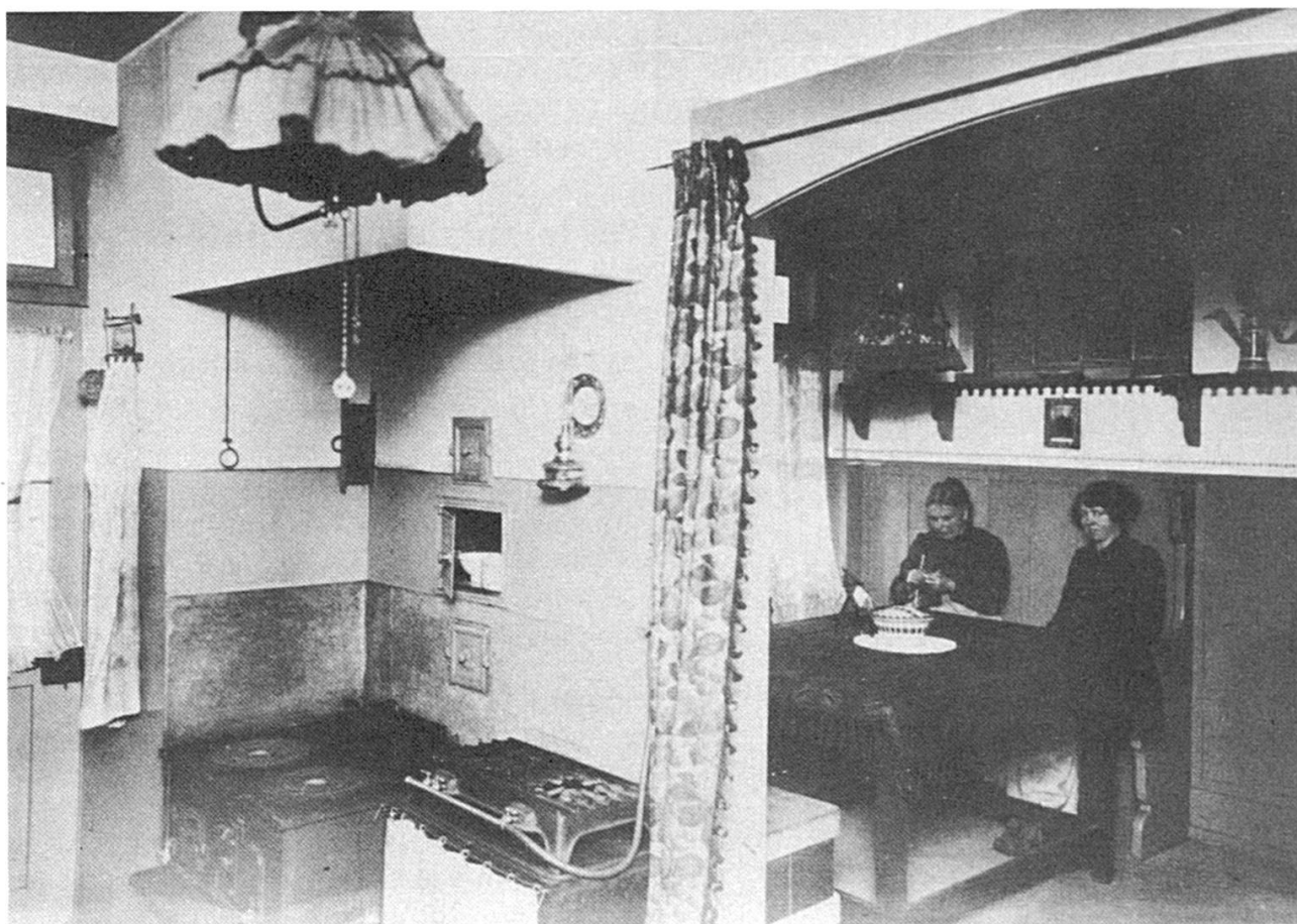
A l'intérieur de la "maison grise", dernière maison à la sortie de Choindez en direction de Moutier. Cuisine et séjour.
