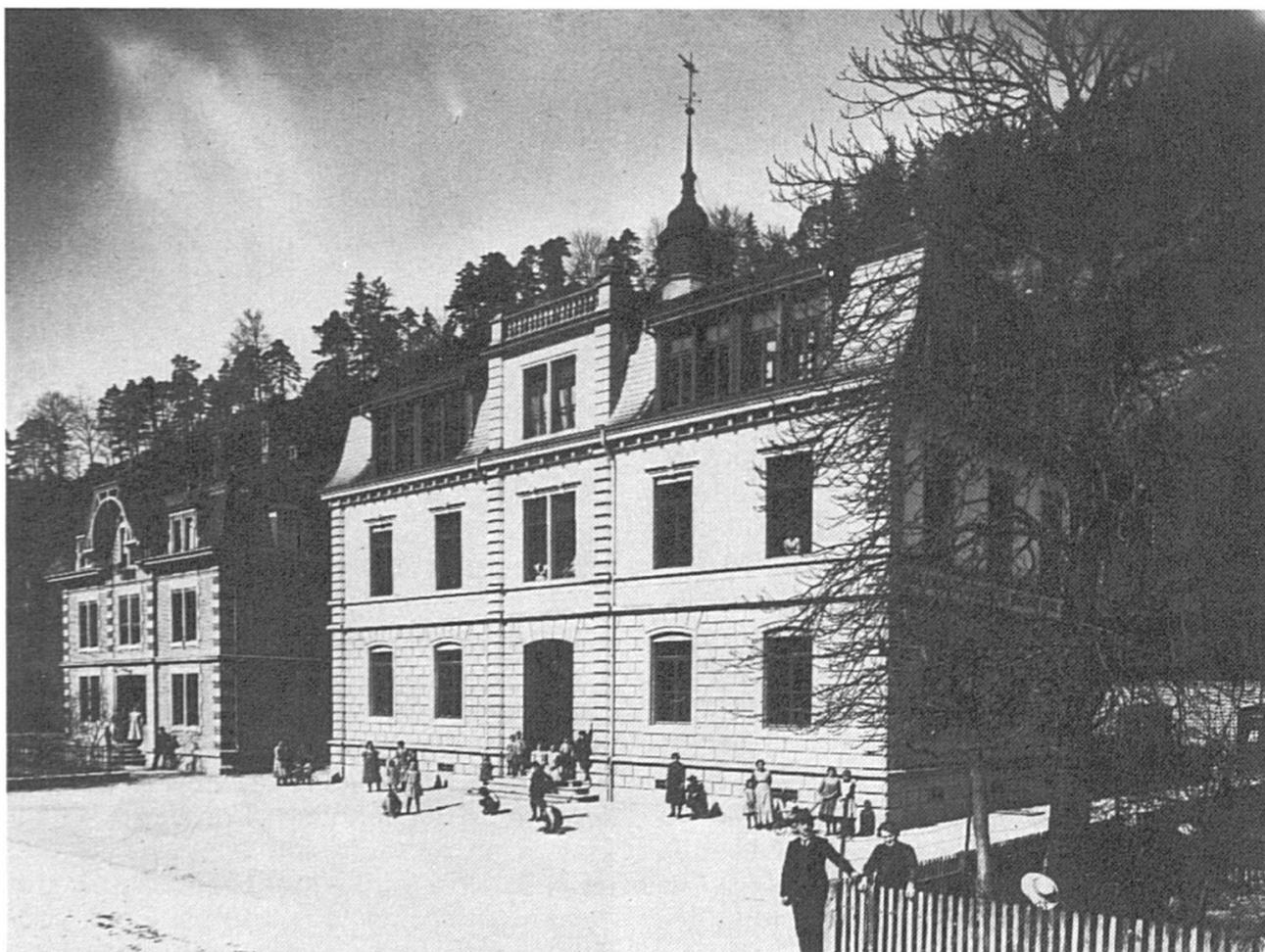
*L'école et le magasin. Ces bâtiments ont été construits avec les "briques de Choindez", fabriquées avec du ciment de laitier, mélange de chaux et des matières vitreuses recueillies lors de la fonte du minerai de fer dans le haut fourneau.*
