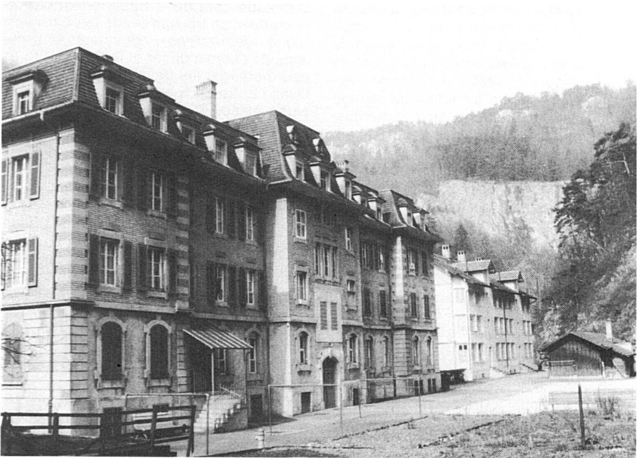
La "Logierhaus" no 1 et la "Felsenau" vues de l'arrière (photo Ch. Torriani, 1990).
