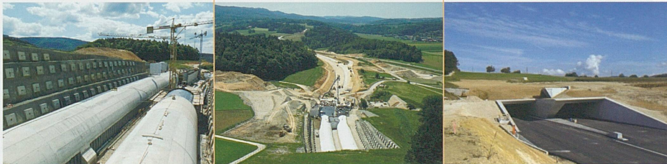
Différentes étapes de la construction d'une extrémité du tunnel du Banné près de Porrentruy (photos A16 info)
