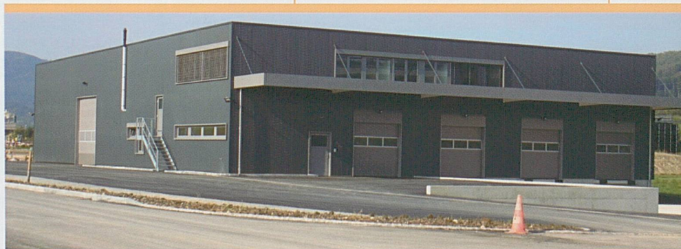
La construction industrielle en plein développement dans le Jura
