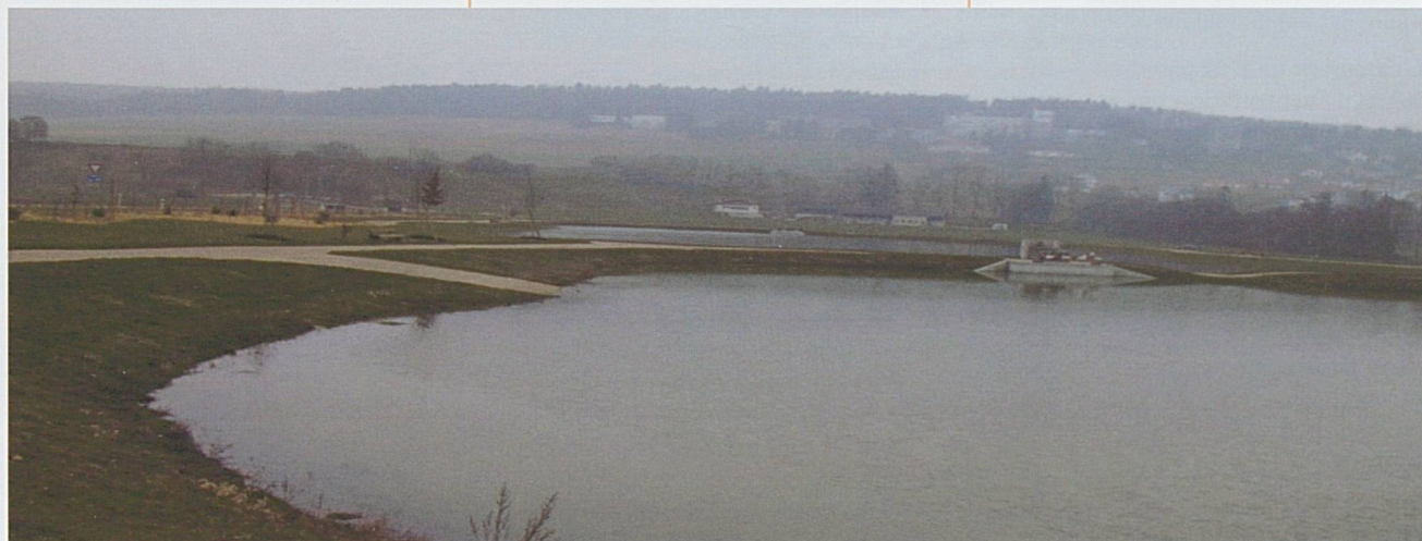
A16, section 3, Bassins de rétention/sécurité, Jonction Ouest Porrentruy
