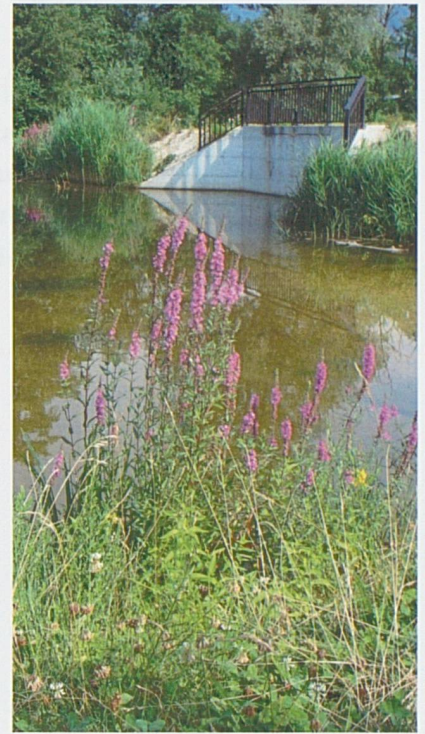
A16, section 7, Ouvrage de rétention-filtration, Delémont Ouest, Sorne rive droite
