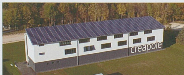
Installation solaire photovoltaïque de Créapôle au Noirmont
