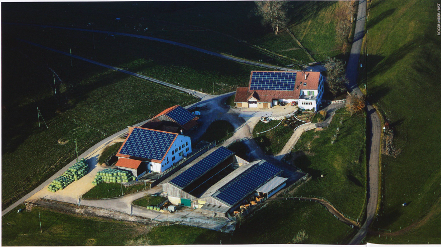
Objectif: donner un coup d'accélérateur à une plus grande indépendance énergétique (ci-dessus, des panneaux photovoltaïques).
