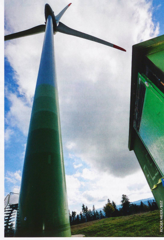
Le chantier énergétique jurassien est gigantesque et nécessite d'avancer par palier.
