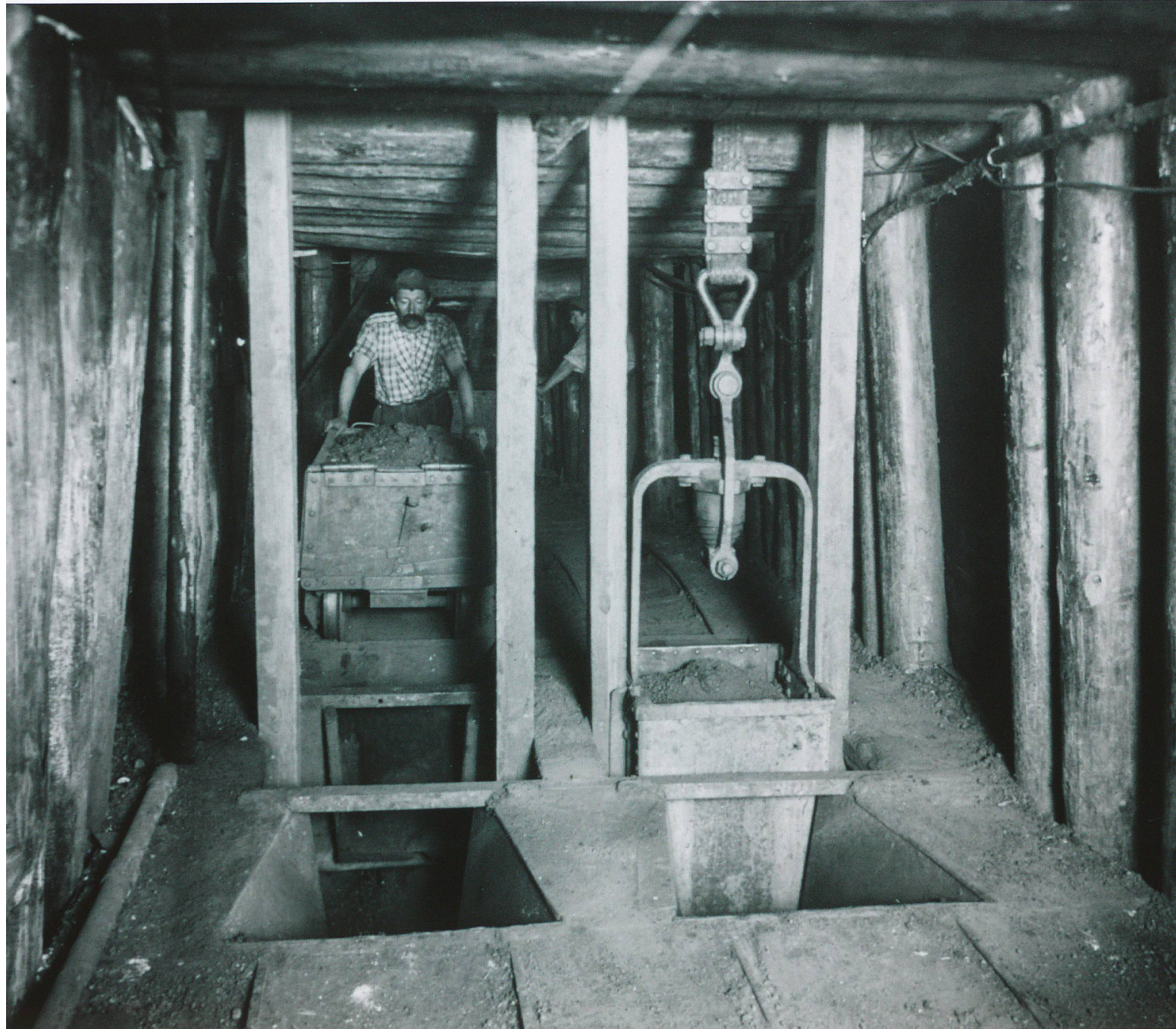
Puits de mine à Delémont: chargement du minéral dans le cuveau qui le remontera en surface.
