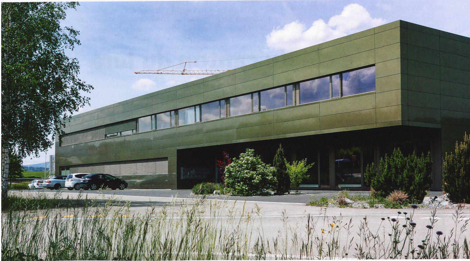
La zone Innodel, entre Courrendlin et Delémont, qui accueillera l'antenne jurassienne du Parc suisse de l'Innovation.
