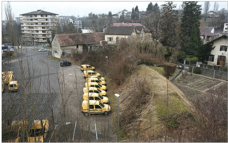
Fig. 7. L'ancien moulin de Saint-Julien, 2008 (OPS). On distingue, au premier plan, la trace du bassin d'accumulation, et, à l'arrière-plan, le moulin transformé vers 1880 en minoterie.
