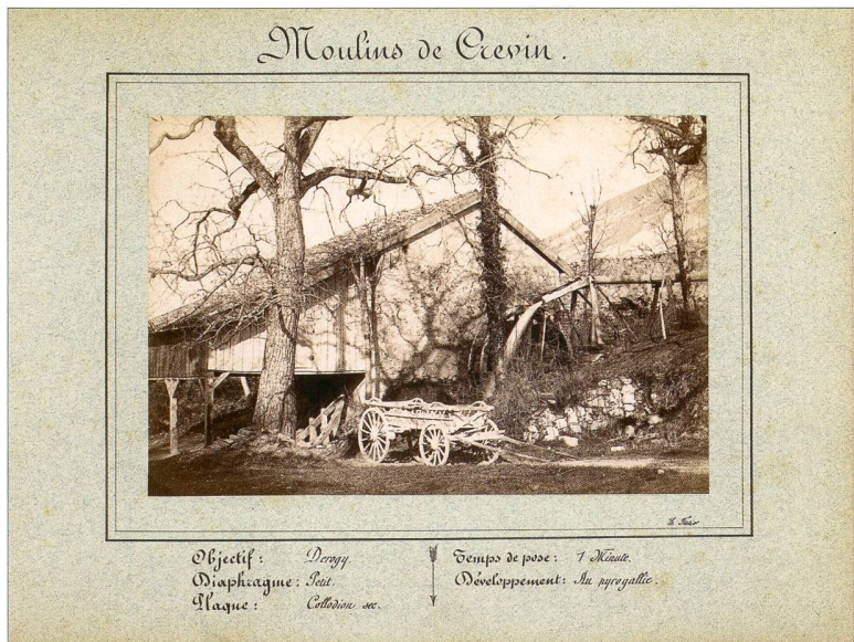
Fig. 3. Le premier des trois moulins de Crevin, vers 1880 (BGE-CIG). Le site comprenait trois bâtiments, tous démolis. Seul subsiste aujourd'hui son imposant battoir, entreposé en contre-bas de la route de la Croix.
