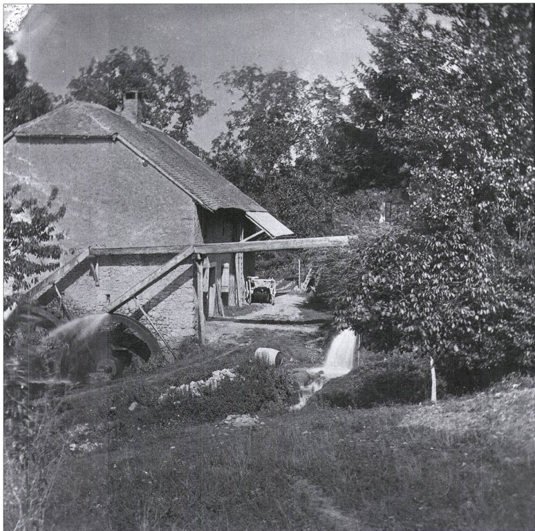
Fig. 2. Le moulin d'Etrembières vers 1870 (BGE-CIG). Le site comprenait trois bâtiments dont seul subsiste aujourd'hui le principal, malheureusement délesté de ses deux roues spectaculaires.
