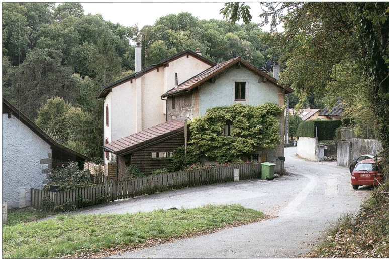
Fig. 5. L'ancien moulin de Ternier, 2017 (OPS). Les roues de l'établissement étaient installées à la hauteur de l'appentis en bois. Elles étaient actionnées par l'eau contenue dans un bassin qui se développait au premier plan.
