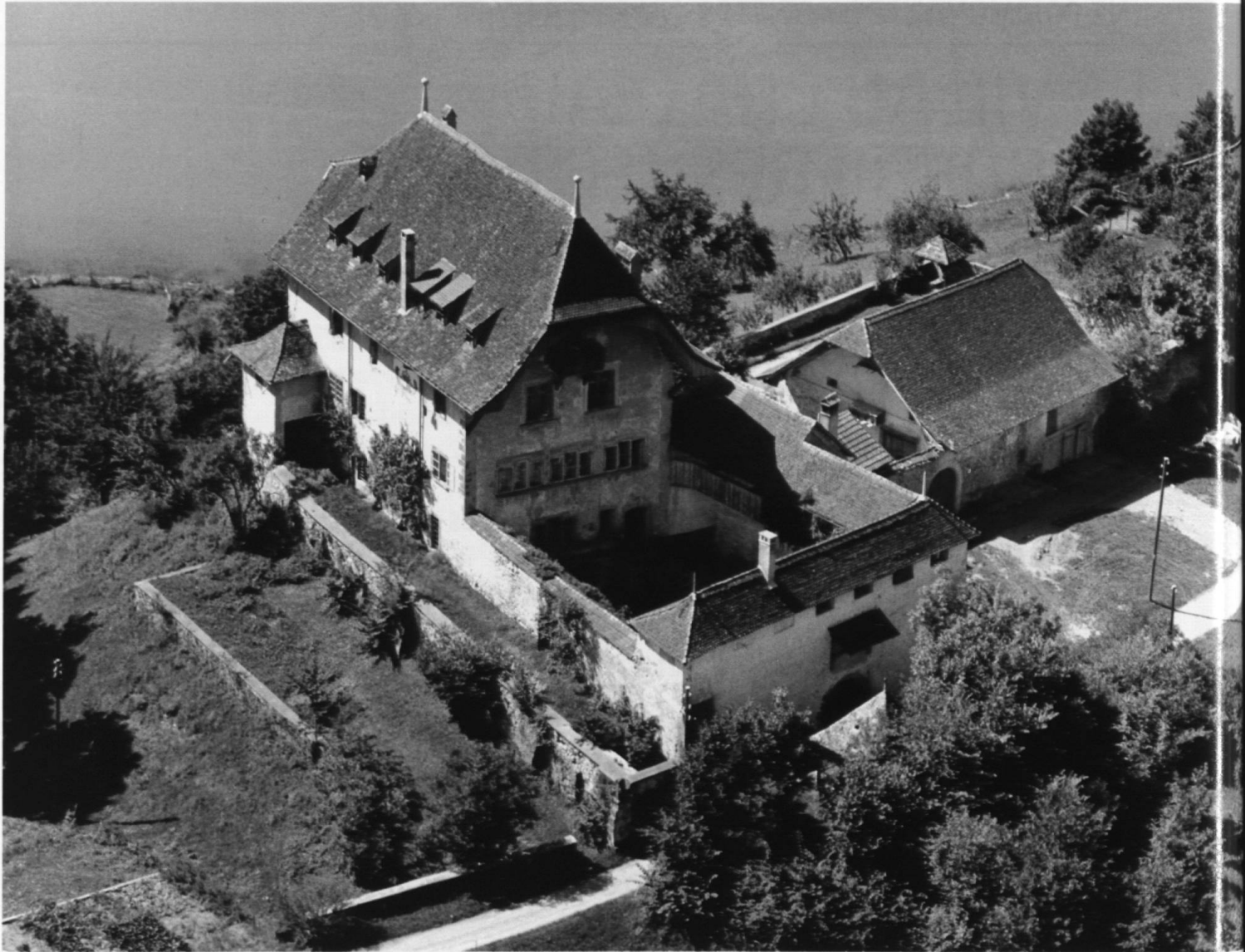
Vue aérienne du château de Corbières dans les années 1960. La première mention d'un édifice remonte à 1150. C'est en 1850 que l'Etat mit en vente le château ex-baillival, où plusieurs propriétaires se succédèrent jusqu'en 1927. Il fut alors offert aux Bénédictins. Photo René Bersier
