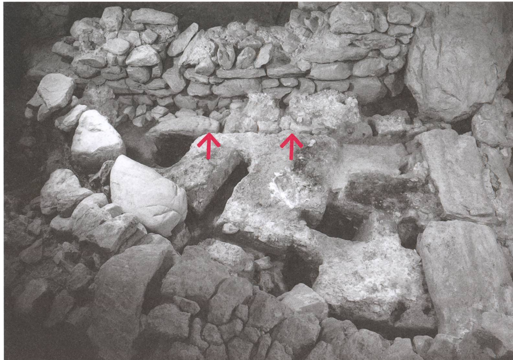
Abb. 252: Tomils, Sogn Murezi. Westannex, Raum J. Fundament (1074) entlang der Nordwand (Pfeile). Blick nach Norden.
