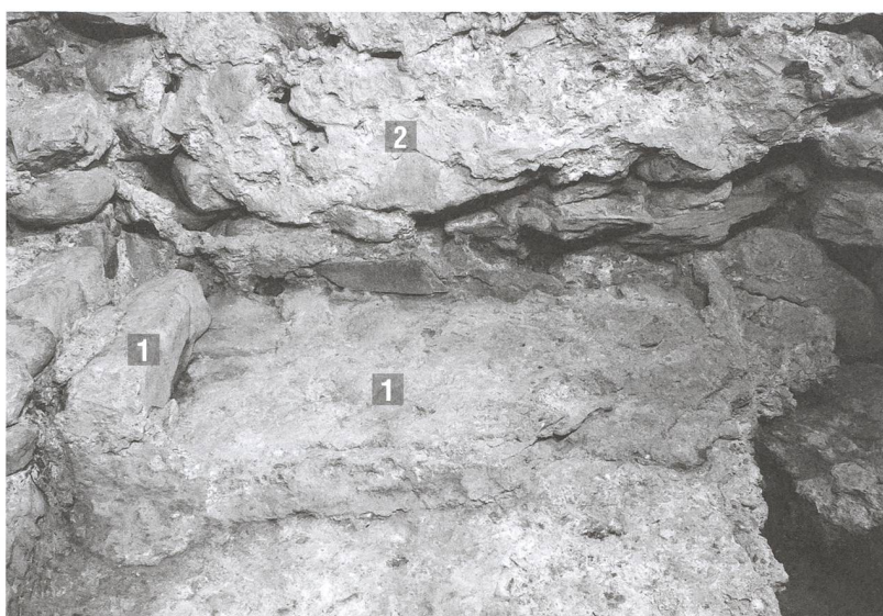
Abb. 248: Tomils, Sogn Murezi. Südannex E. 1 Stufe (1032) zu 2 (später zugemauertem) Eingang (1031). Blick nach Süden.
