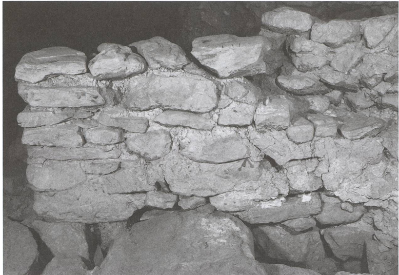
Abb. 257: Tomils, Sogn Murezi. Westannex, Raum J. Mauerwerk der Südmauer (960) im Bereich des Einganges mit Resten von Wandverputz. Hinweise auf eine Tür sind nicht gegeben. Blick nach Süden.
