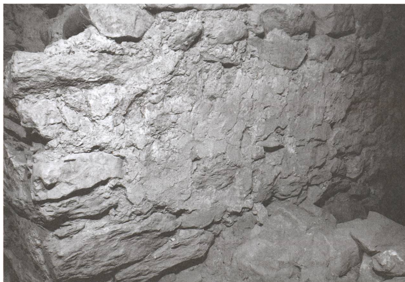
Abb. 233: Tomils, Sogn Murezi. Südannex E, Westerweiterung. Der Mauermörtel wurde gross- flächig an der Fassade verstri- chen. Blick nach Nordosten.
