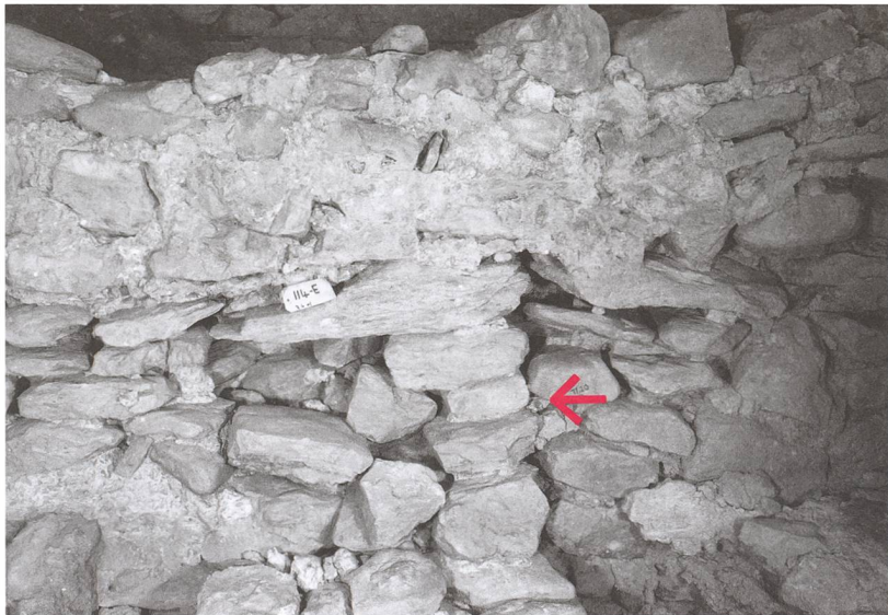
Abb. 229: Tomils, Sogn Murezi. Südannex E, Westerweiterung. Die Südmauer (333) der Westerweiterung stößt an die originäre Südwestecke des Annexbaus (Pfeil). Blick nach Süden.
