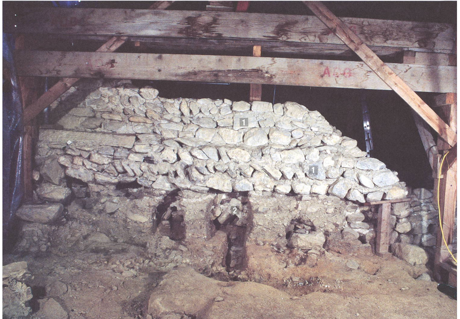
Abb. 396: Tomils, Sogn Murezi. 1 romanische Kirchenwestmauer (71), 2 frühmittelalterliche Kirchenwestmauer (78). Blick nach Osten.
