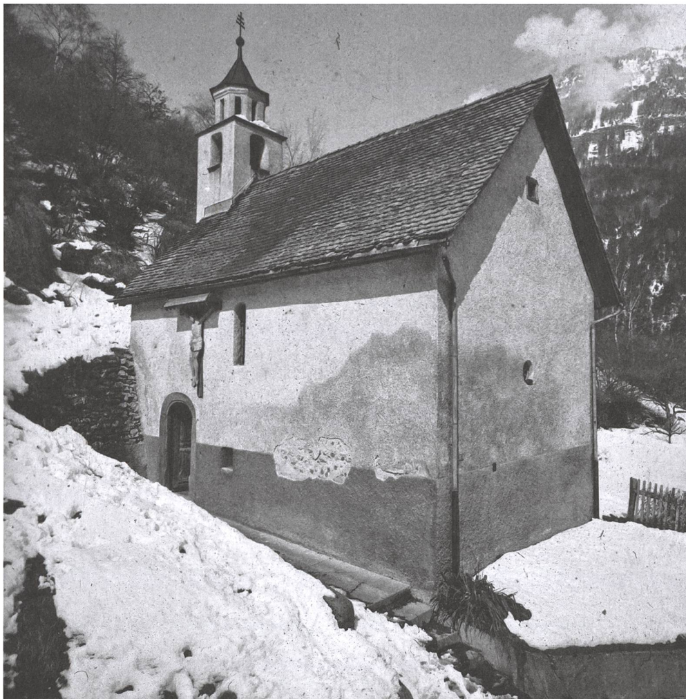
Abb. 12: Domat/Ems, Sogn Pieder. Zustand der Kirche im Jahr 1975 vor Beginn der archäologischen Untersuchungen. Blick nach Westen.
