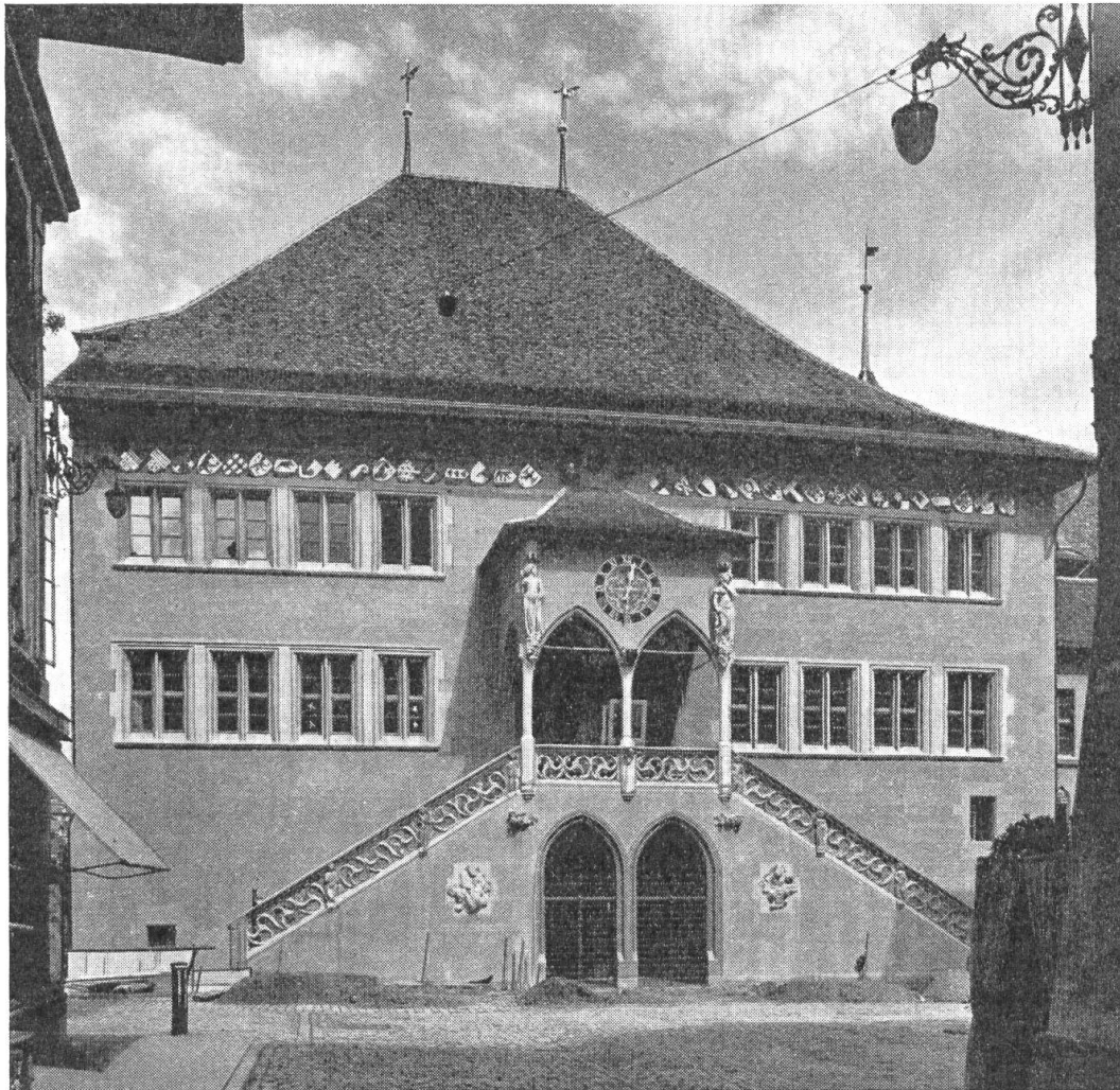
Fig. 55. Das Berner Rathaus nach der Renovation von 1940/42. Unter dem Dachgesims erkennt man deutlich den farbigen Wappenfries mit den Schildern der Amtsbezirke.
