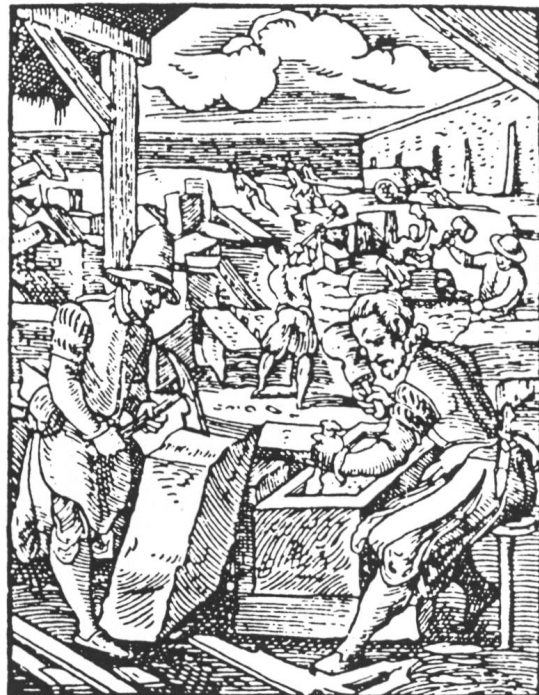
Fig. 34 Tailleurs de pierre, gravure de Jost Amman, parue en 1568. L'artisan de gauche se sert du pic pour tailler la pierre et celui de droite d'un ciseau et d'un maillet en bois déjà usé. Il est aussi sur un tabouret à un pied. On distingue au premier plan une partie d'un niveau de maçon à fil à plomb.
