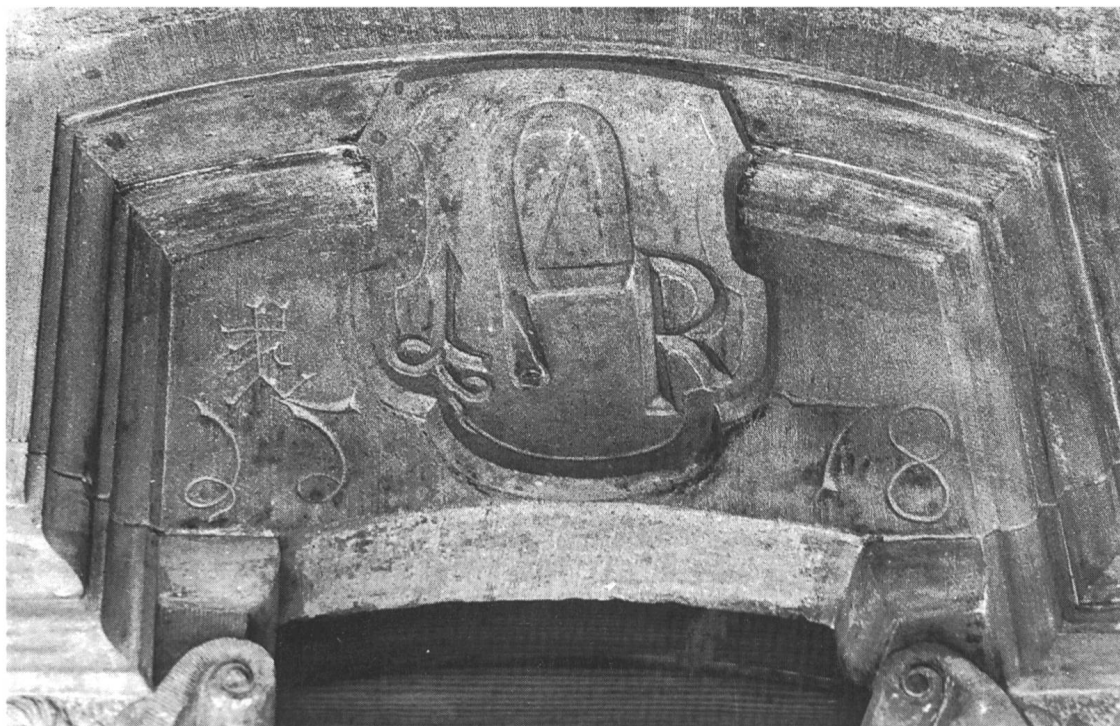
Fig. 44 Emblème de tuilier, 8, rue de l'Eglise (1578). Linteau de la porte d'entrée de la maison orné d'un gabarit à tuiles plates, flanqué des initiales I R (pour Jacob Rysz) et d'un signe lapidaire. L'emblème de tuilier représente en général un gabarit à tuiles plates, deux gabarits entrecroisés de manière à former un motif ressemblant à un cœur, ou encore un gabarit à briques et un gabarit à tuiles entrecroisés. Le bourgmestre-tuiliier Jacob Rysz transforme l'actuel 8, rue de l'Eglise entre 1574 et 1578. Chaque étape des travaux est datée et porte son emblème: le puits (1574), la maison d'habitation (1578), l'aile en colombage (1579–1580) et la porte cochère (1580).
