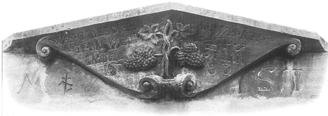
Fig. 16 Le façade Ouest de l'immeuble est ornée d'une fenêtre en oriel qui surplombe une inscription décorée de pampres: WAS GOD ES DICH AN WAS ICH GEBAVWE (N) HAP (Was geht es dich an, was ich gebauen habe?). Elle est rédigée dans la tradition des inscriptions de maisons s'adressant aux passants. Le texte est suivi du nom de propriétaire en toutes lettres: Bartel Itenn. Ce dernier, membre du Conseil de la ville en 1586 est fermier de la cour du Grand Chapitre de la Cathédrale de Strasbourg à Rosheim. Comme Paulus Brotbecker, rue du Coin ou Jacob Ryss, rue de l'Eglise, il a transformé une maison médiévale dont subsistent encore d'importants vestiges. Un signe lapidaire et les initiales M S T qui sont peut-être celles du sculpteur, sont gravés sous le texte.
