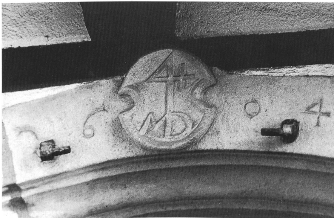
Fig. 40 Emblème de marchand avec initiales M D, sur une fenêtre d'échope, datée de 1604, 92 rue Principale. On distingue encore de part et d'autre de l'écu les deux gonds en fer qui retenaient la partie supérieure du volet. La partie inférieure pouvait se rabattre sur des tréteaux et servir d'égal.
