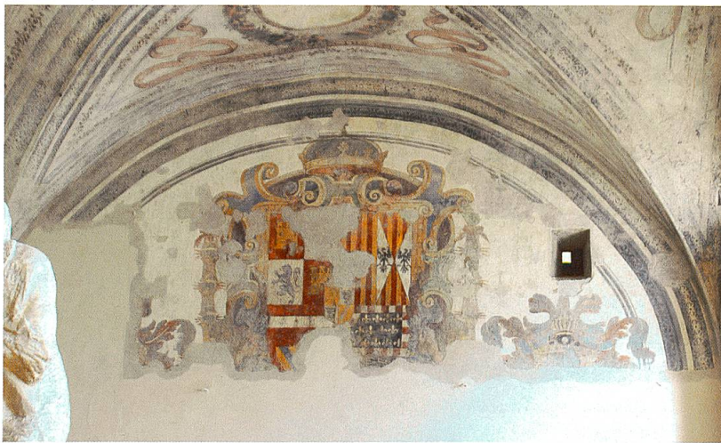
Fig. 3 Controfacciata Nord, Ospedale Spagnolo, Castello Sforzesco.
