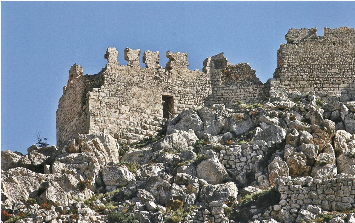
Fig. 5 – Bastion oriental du château de Chalki (cl. JBV).
