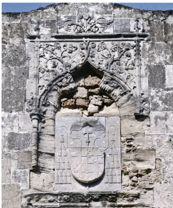
Fig. 18 – Cadre sur la courtine orientale protégeant le port (cl. JBV).
