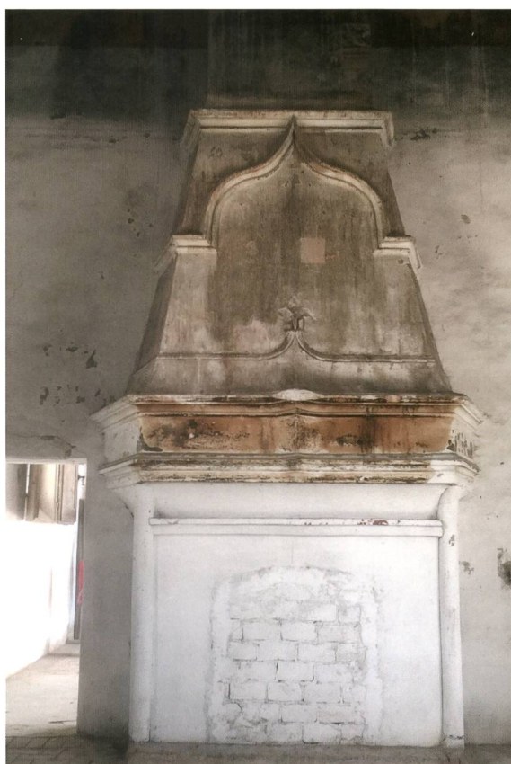
Fig. 17 Camino monumentale, Castello di Mirabello (PV).
