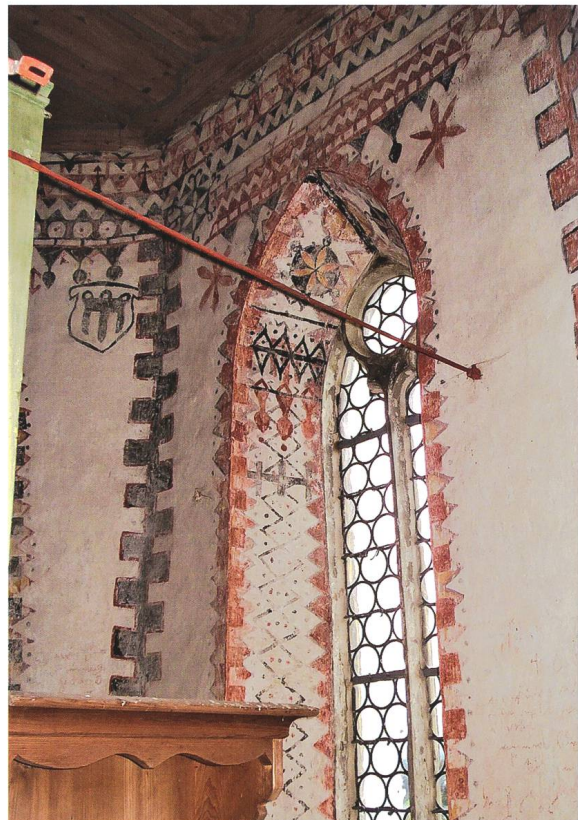
Abb. 9: Altarraum, Ostfenster links oben.
