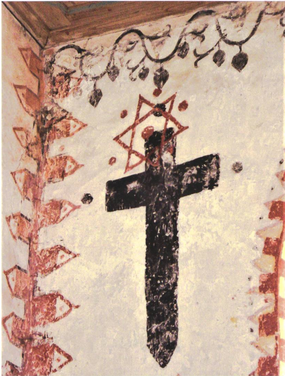
Abb. 22: Langhaus südwand vor dem Chorraum mit Kreuz und Davistern.
