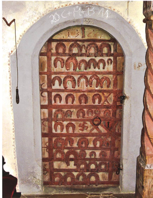
Abb. 18: Chornordwand, Tür zur Sakristei, 1566 & re 1495.
