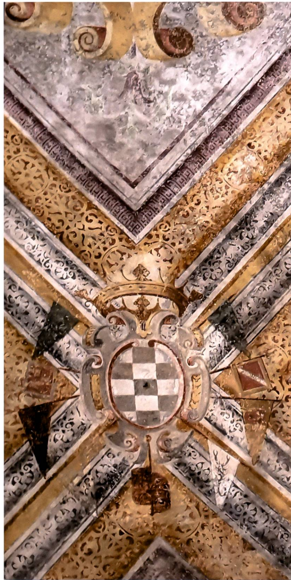
Fig. 13: Arma di don Fernando Álvarez de Toledo y Pimentel, Castello Visconteo, Pavia (PV).
