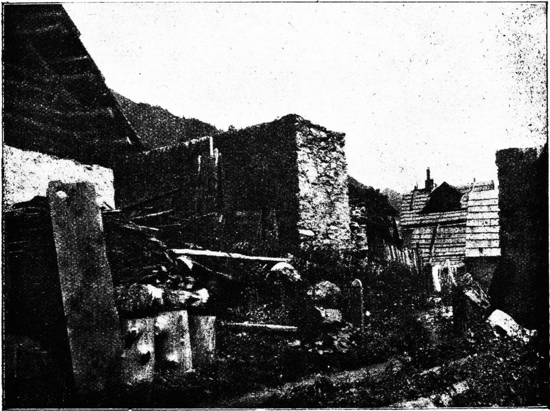
Lawinenmauerlücke in Vedretto.
