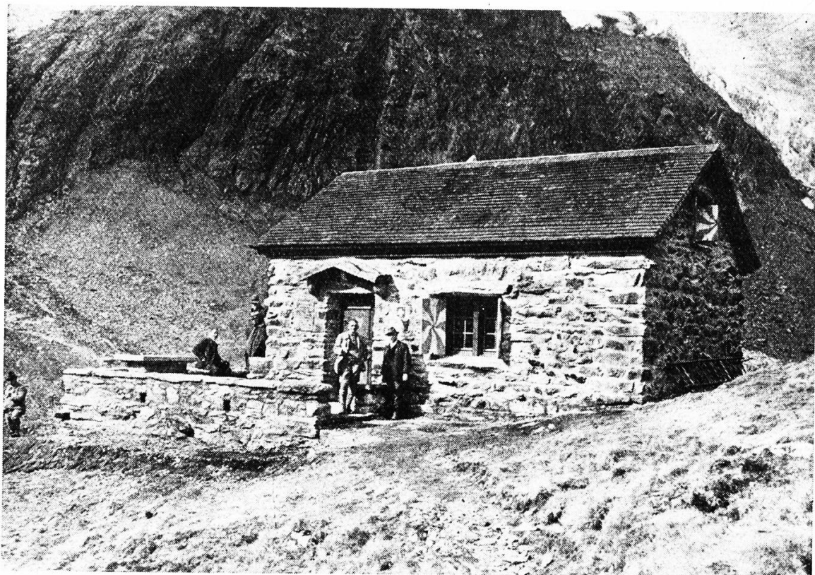
Die neue Boralphütte.
