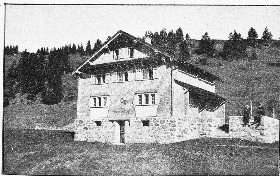
Utohaus auf der Zbergeregg. — Ansicht von Süden.
