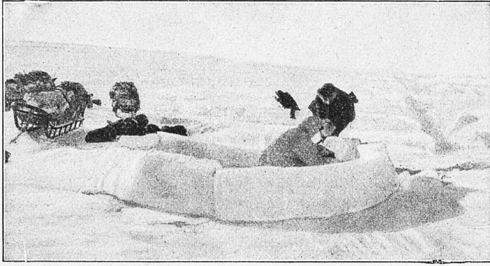
Abbildung 4. Bau einer Schneehütte, unterer Teil.
