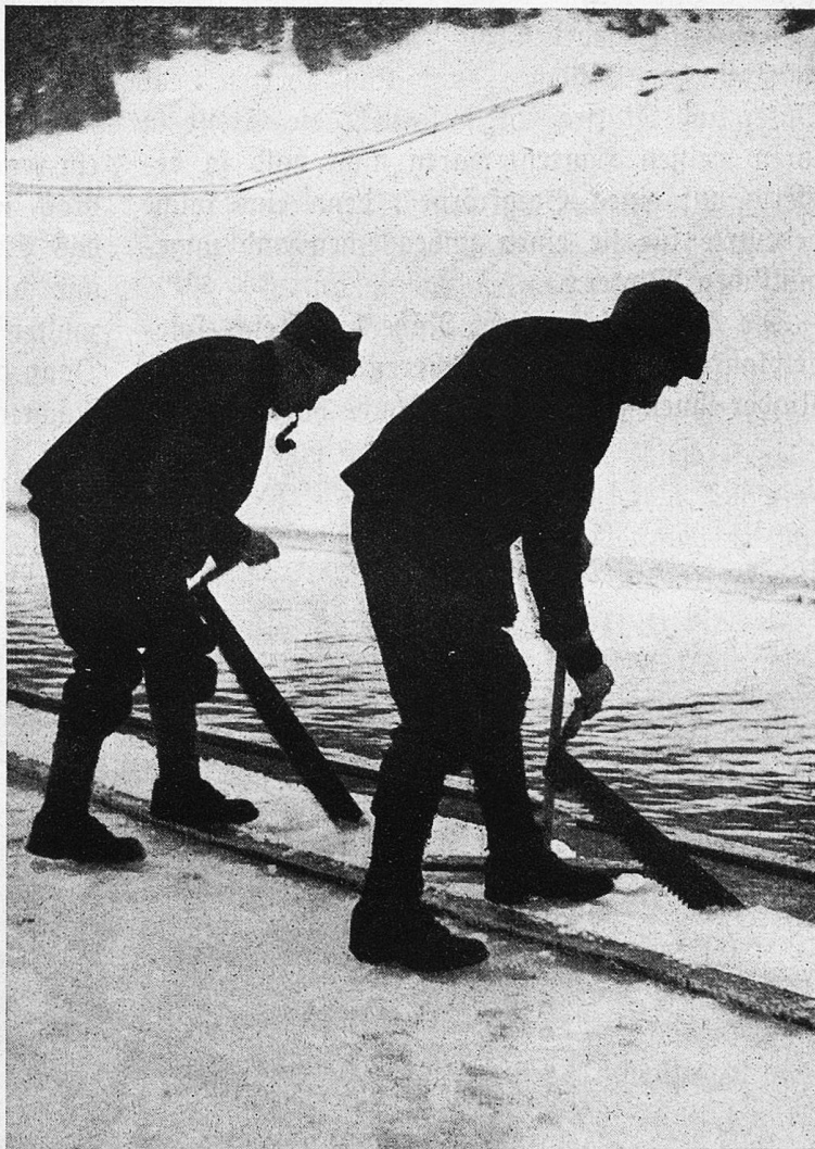
Das Eis wird in quadratförmige Blöcke zersägt
